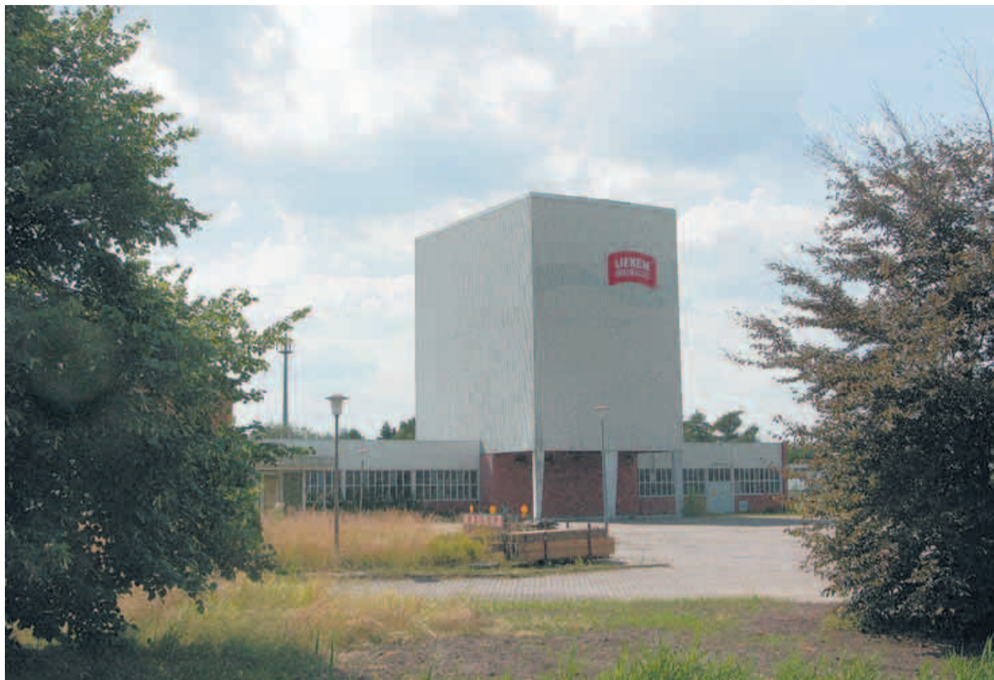
Seit Anfang 2007 liegt das ehemalige Kamps-Gelände am Süderquerweg brach.
